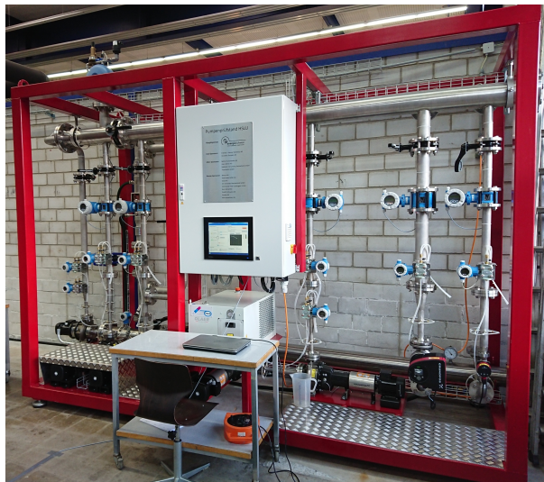
Abbildung 1.1: Der Pumpenprüfstand im Fluid-Labor des CC FMHM
